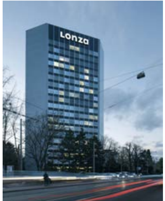
Lonza-Hochhaus an der Münchensteinerstrasse, erbaut 1960–1962
